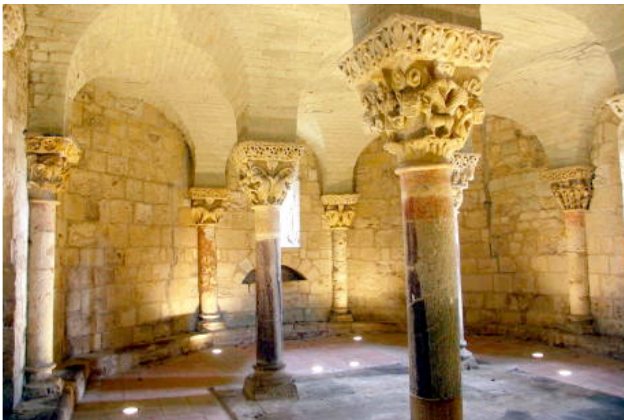
Vue intérieure partielle de la crypte avec, contre les murs, des colonnes "engagées" et, au centre, des colonnes "isolées". Au premier plan, un chapiteau "historié". On remarque aussi, au-dessus des chapiteaux, les "tailloirs", finement sculptés.
