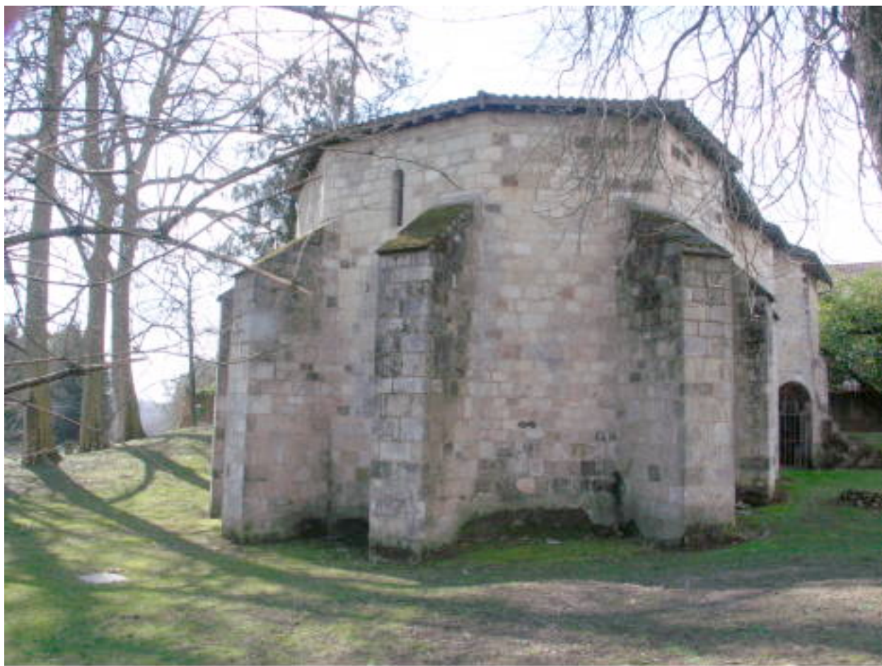
Extérieur de la crypte (côté EST) : On remarque la déclivité accusée du terrain et les puissants contreforts qu'il a fallu construire pour assurer la solidité des murs.
